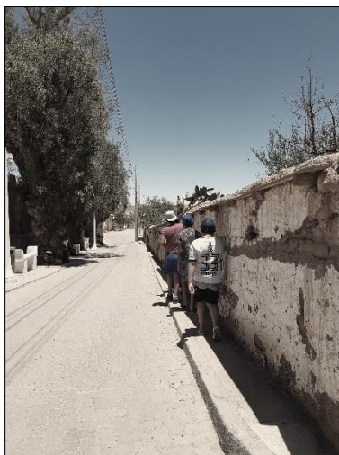
Imagen N°9: contra muro sector rural
