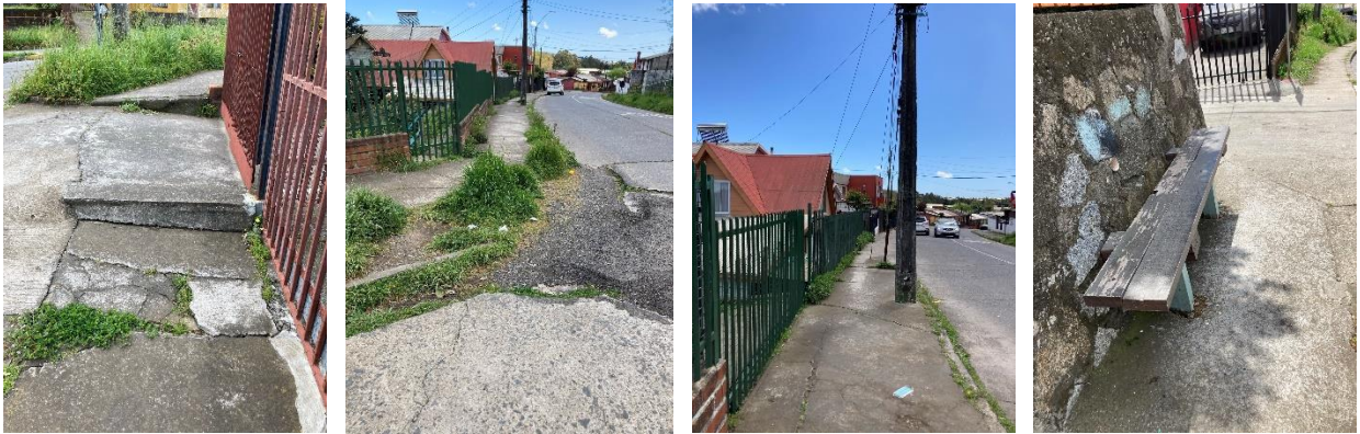
Figura 70. Imagen uno, escalones en acera; imagen dos, cruce por calzada de ensanche en mal estado; imagen tres, obstáculos en vereda; imagen cuatro, asiento hecho por vecinos a un costado de vereda. Fuente: registro propio.
