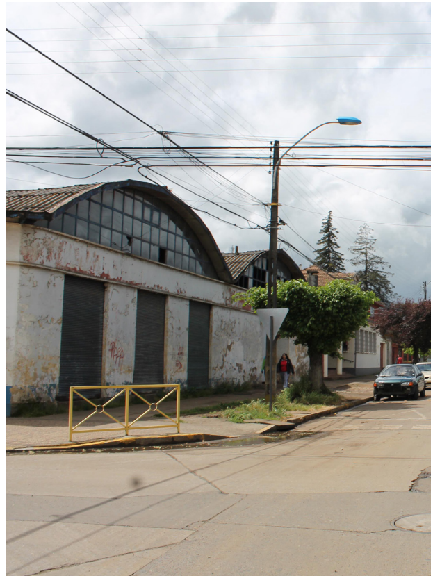
Figura 76. Vista de cubierta abovedada desde el exterior | Fuente: Colección de la autora (2015).
