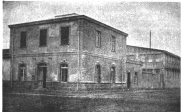
Figura 22. Fábrica de Muebles Traiguén en calle Saavedra con Bulnes | Fuente: Aranda, Llarena y Tejano, 1920.
