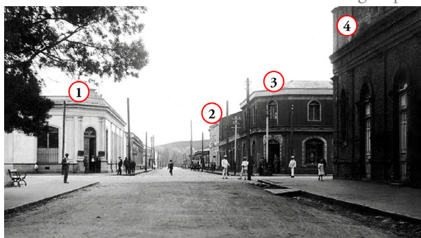
Figura 25. Calle Saavedra frente a Plaza de Armas. 1) Casa Manríquez, 2) Hotel Seen, 3) Librería Alemana, 4) Parroquia SSCC de Jesús | Fuente: Extraída del sitio Fotografía Patrimonial MHN.
