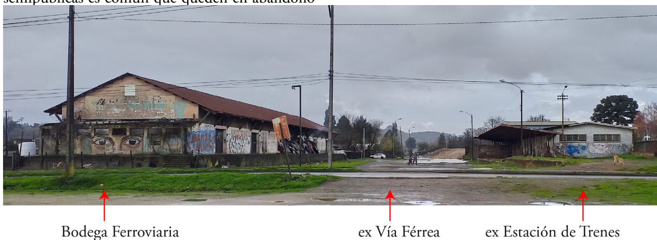
Figura 83. Ex Estación de Trenes y Bodega | Fuente: Gentileza Francisco Jiménez (2020).
