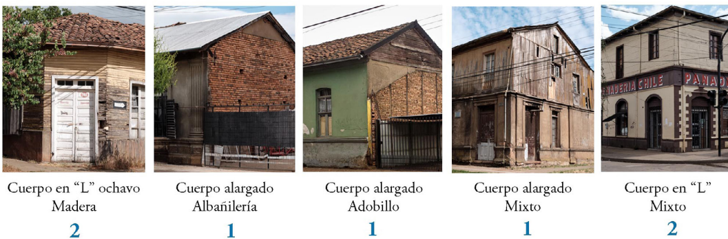
Figura 30. Tipologías de edificios residenciales y mixtos en la época de auge | Fuente: Elaboración propia (2020).
