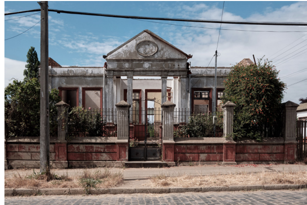
Figura 72. Casa Venturelli, año 2020, en demolición | Fuente: Colección de la autora (2020).
