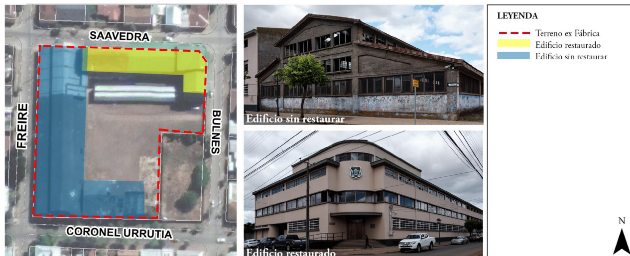
Figura 85. Localización y situación actual de la ex Fábrica de Muebles | Fuente: Elaboración propia (2021).
