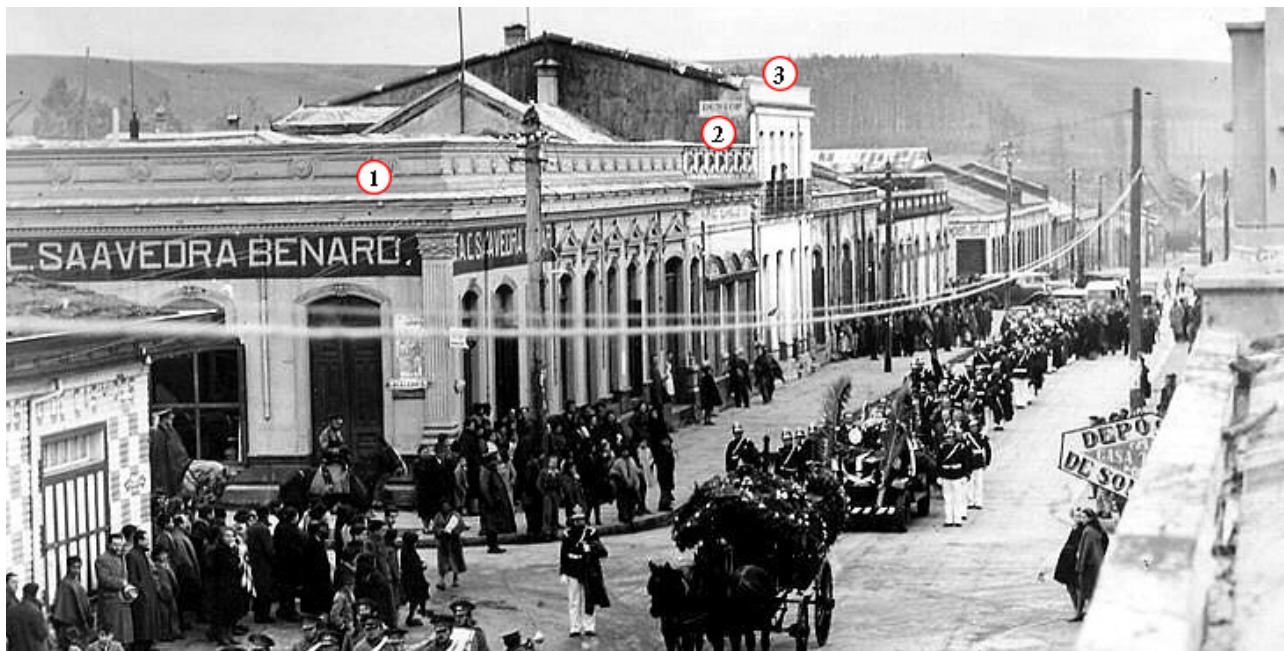
Figura 24. Vista panorámica calle Santa Cruz. 1) Saavedra Benard y Cía. o Casa Kaplan, 2) La Parisiense, 3) Botica del Pobre | Fuente: Extraída de sitio Traiguéninos con Historia: https://www.facebook.com/groups/27645642143 .
