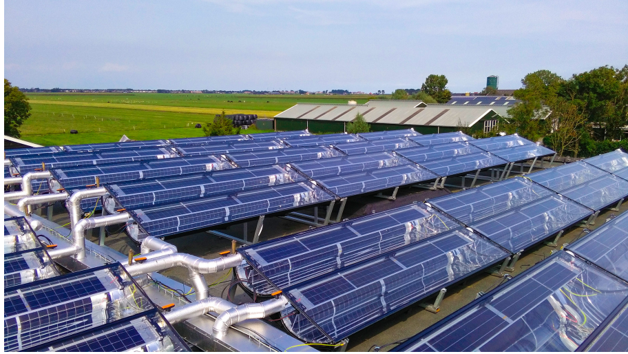
Figura 2.12: Instalación de colectores Solarus.
