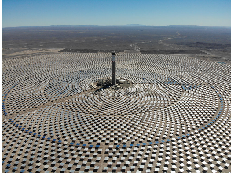
Figura 2.6: Vista panorámica de torre solar y campo de helióstatos [9]
