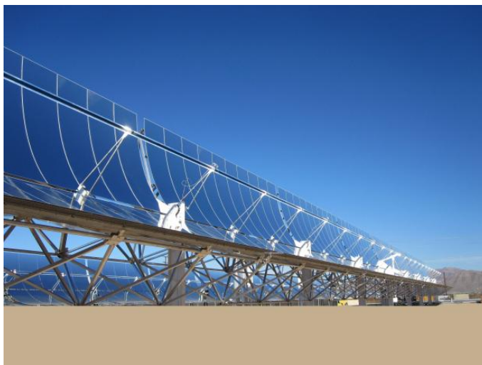
Figura 2.9: Instalación de PTC
