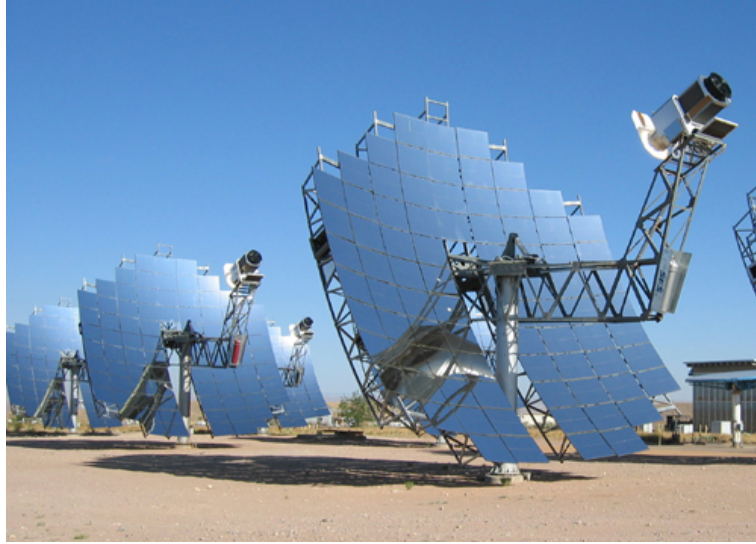
Figura 2.7: Campo solar de discos parabólicos con Motor Stirling en su punto focal.
