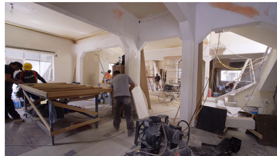
▲ Figura 75: Fotograma extraído directamente del documental "Camino a Roma". En la imagen se aprecia a trabajadores en el set principal de la casa, la que se encuentra en un estado de obra gruesa.
