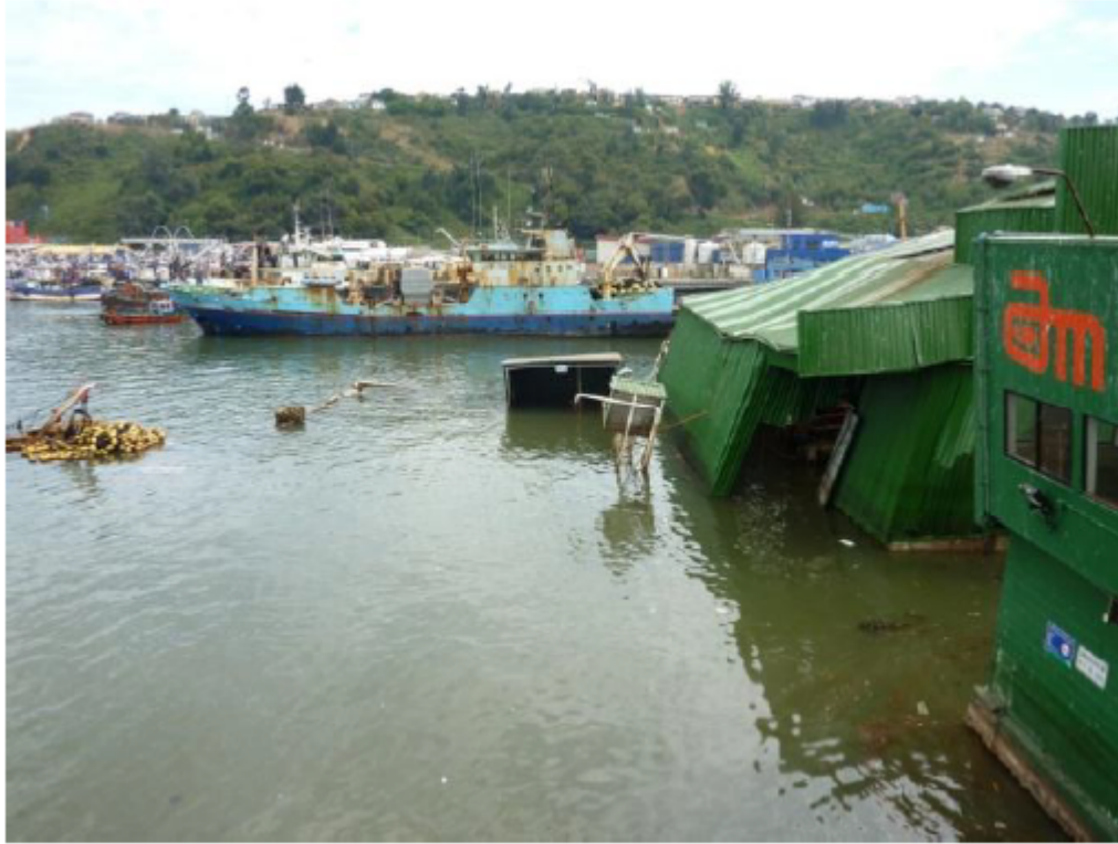
Figura 2.5: Hundimiento bajo el mar explanada noroeste planta de alimentos marinos, Torres (2014).
