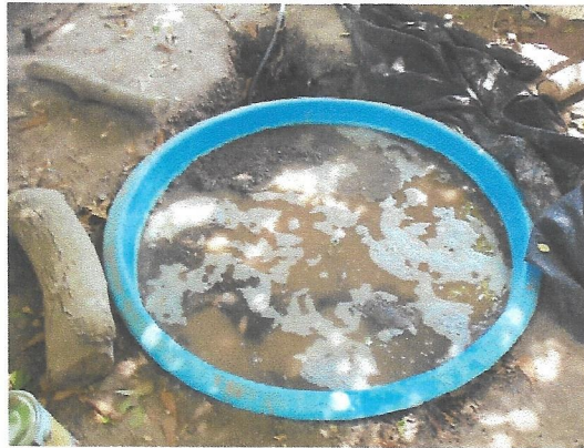
Figura 4. Incorporación de aguas grises para comenzar el tratamiento.
