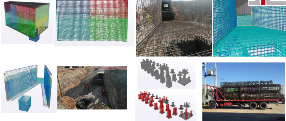
Figura 4.24: Coordinación de modelo y lo que se realiza in situ. Fuente: Presentación Aceros Arequipa, I Congreso Internacional VDC.
