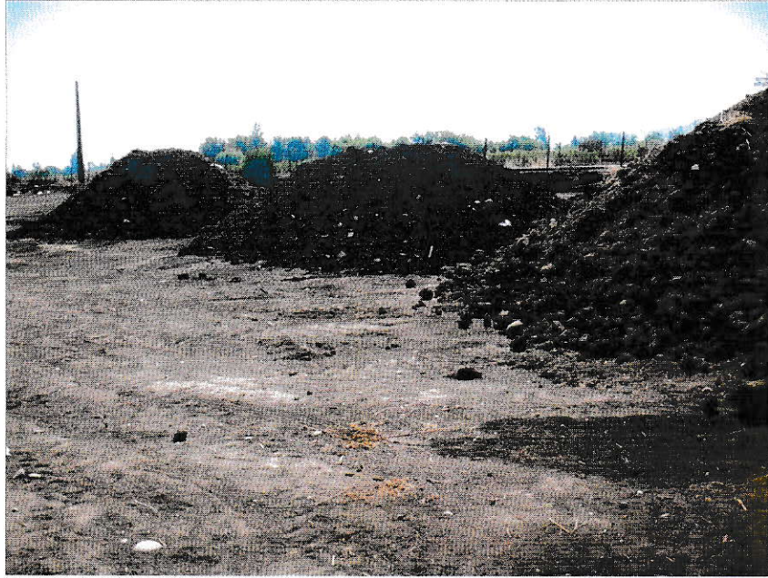
Figura 39. Fotografía zona de estabilización
