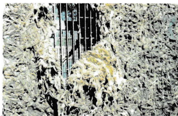
Figura 12. Una rejilla de un canal de suministro de agua es tapada por floraciones de didymo. La superficie oscura son principalmente células, y la clara, tallos (Spaulding & Elwell 2007).
