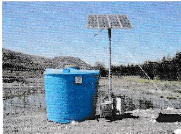
Figura 17: Paneles solares y estanque de melaza
