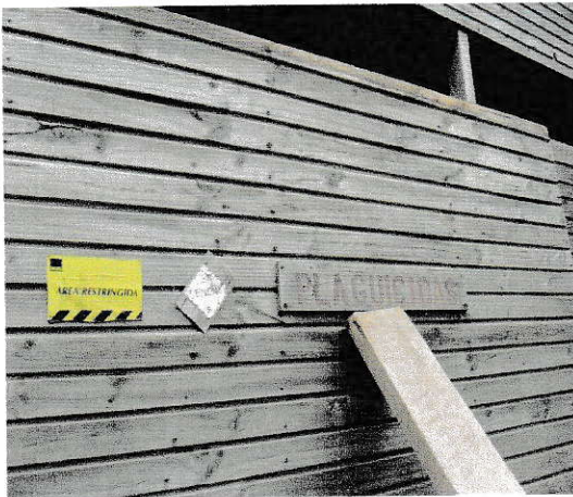
c) Bodega de residuos peligrosos
