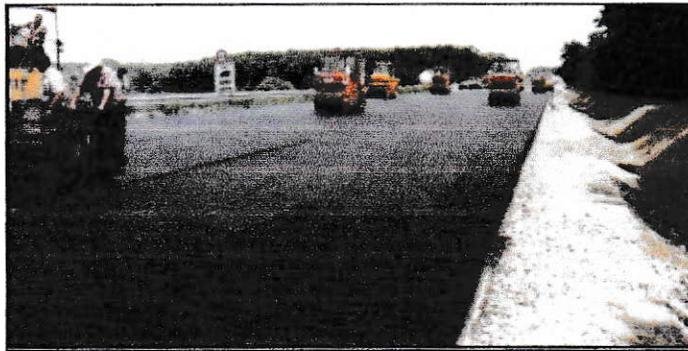
Figura 9. Capa de asfalto hecha con escoria EAF de BSW.
