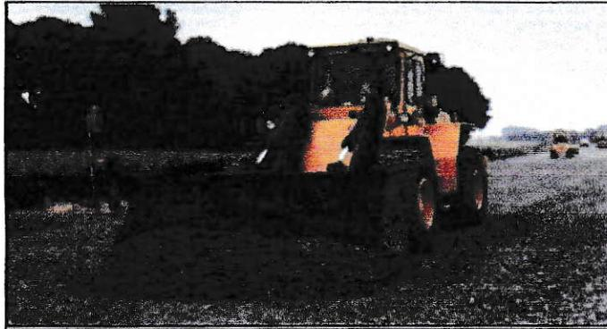
Figura 8. Capa de sub-base hecha con escoria EAF de BSW.
