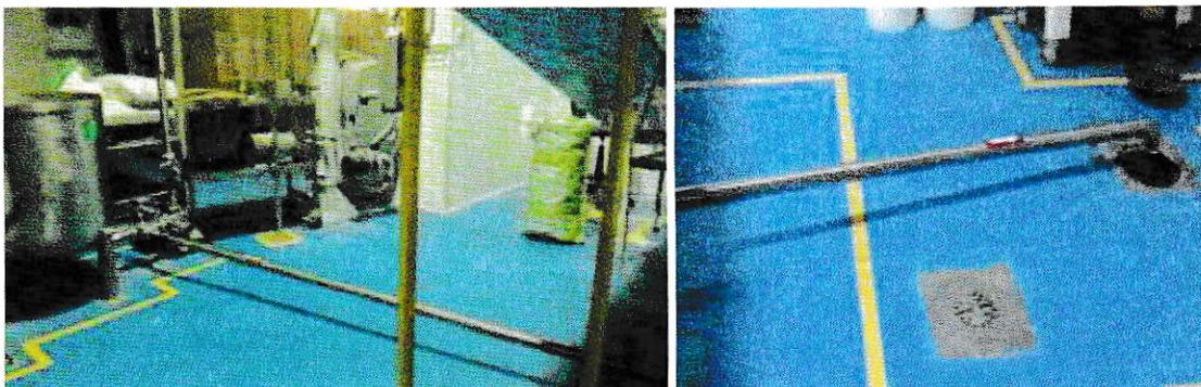
**Figura 60:** Cañería que descarga RIL al desagüe
