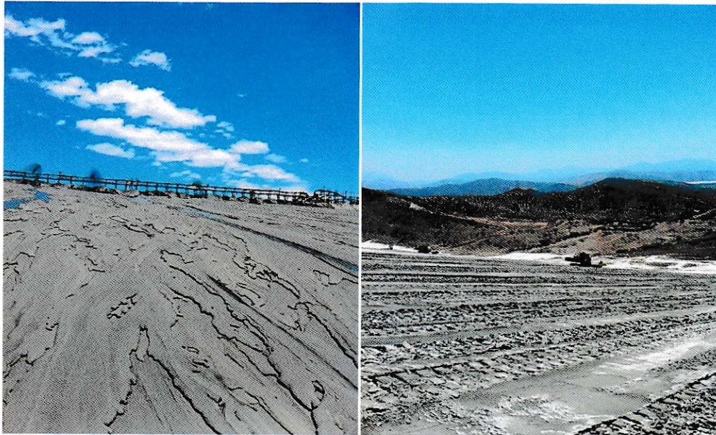
Figura 21. Fotografías de la depositación y compactación de arenas, respectivamente.
