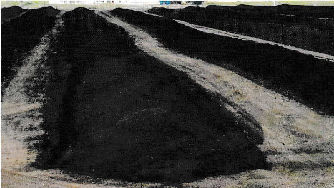
Figura 13: Cancha de secado de lodos en PTAS El Trebal.
