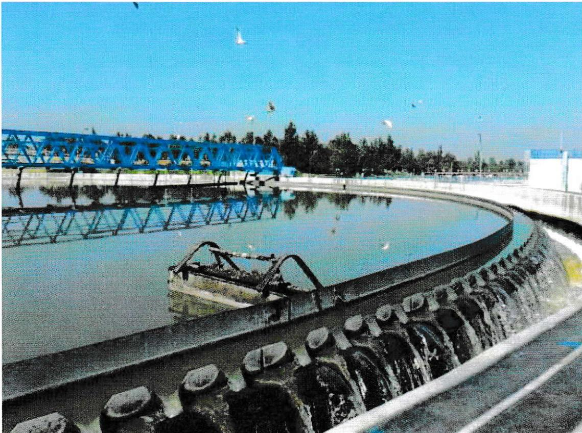
Figura 6: Clarificador primario en PTAS El Trebal.
