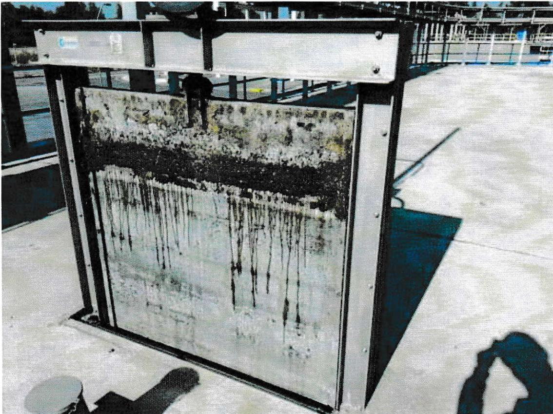
Figura 4: Rejillas de desbaste en PTAS El Trebal.
