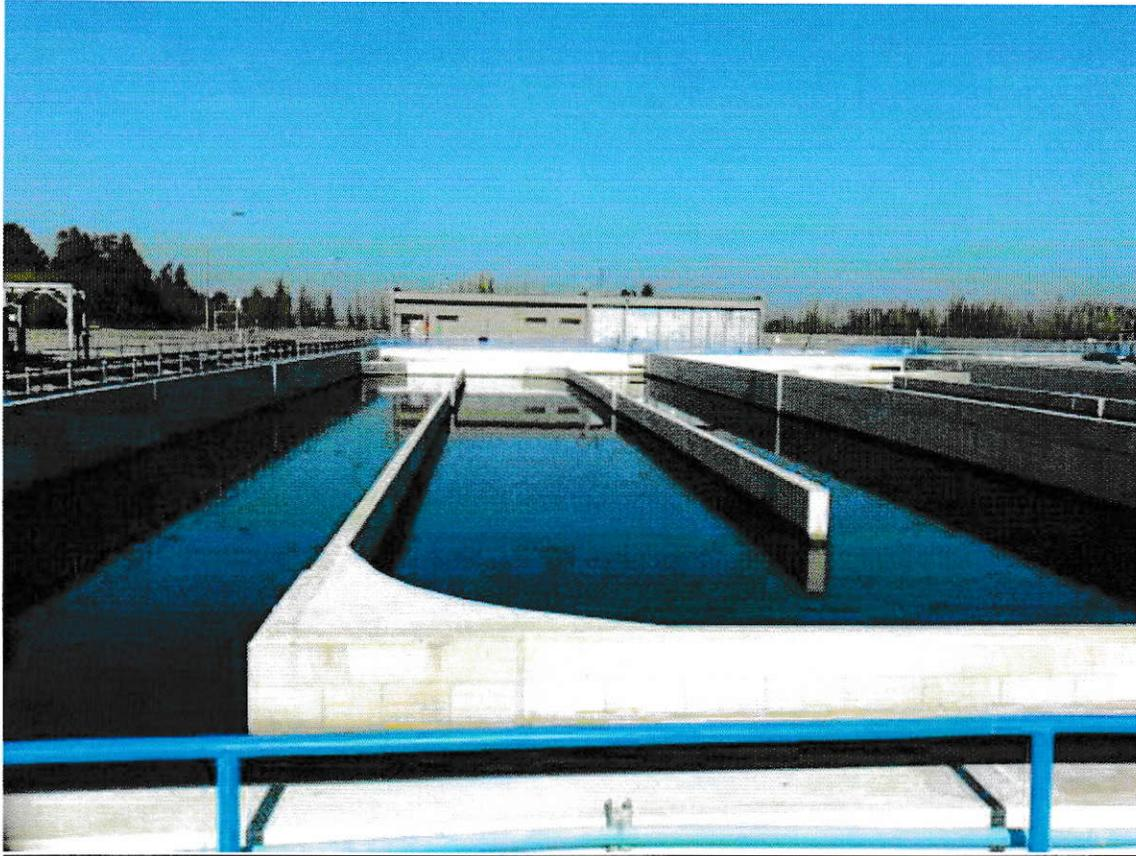
Figura 9: Desinfección, estanques de cloración en PTAS El Treal.
