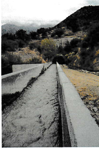
Túnel, Bocatoma y canal de transporte de RIL desde División El teniente (PUC, 2002)
