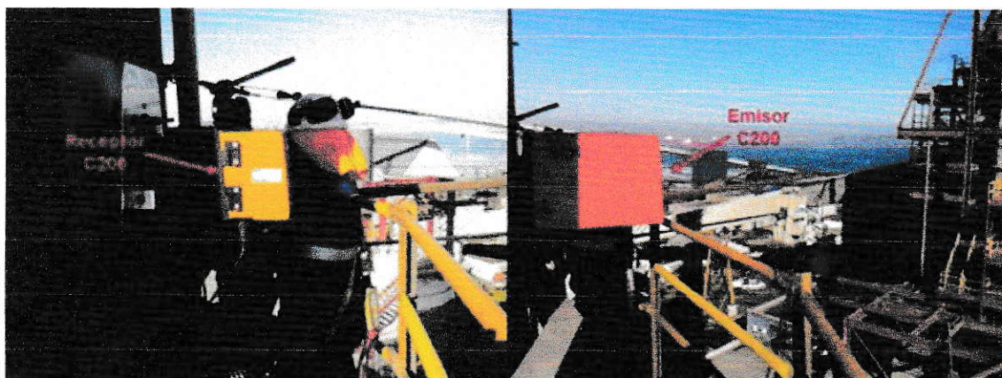
Figura 6. Monitor de Material Particulado instalado en la chimenea de la Unidad de Generación Eléctrica 1 del Complejo Ventanas.
