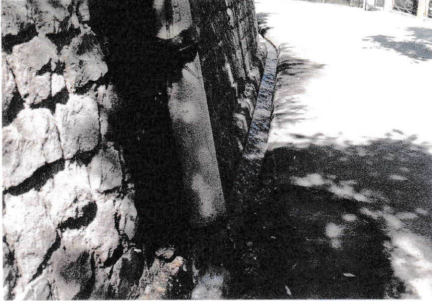
Fotografía N° 1 “Aguas provenientes de la canaleta anterior, por tubo subterráneo”
