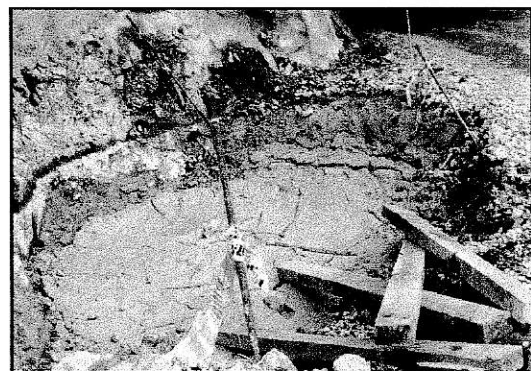
Fotografía 6. CR-25 Piscina de decantación Zona de caída
