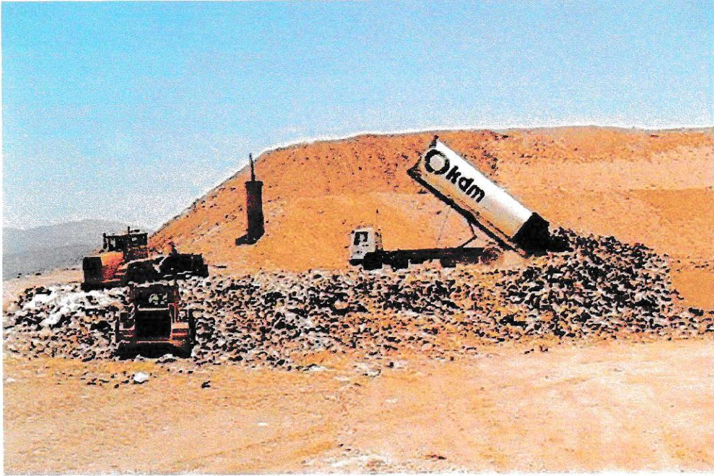
Figura 33: Disposición de los residuos en relleno sanitario
