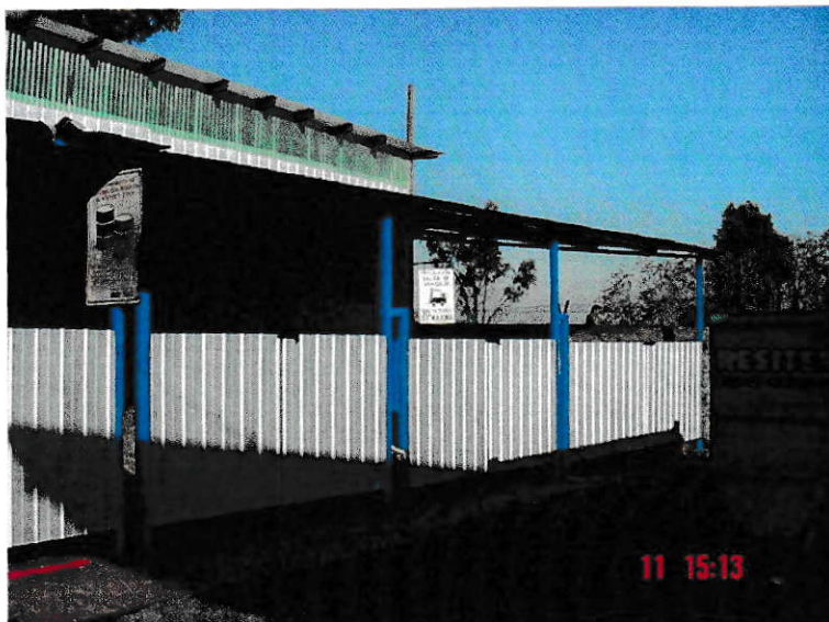
Figura 23. Centro de Acopio Temporal (CAT)
