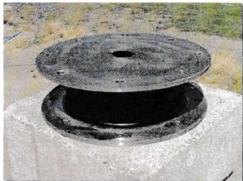
Figura 11. Aislador Sísmico
