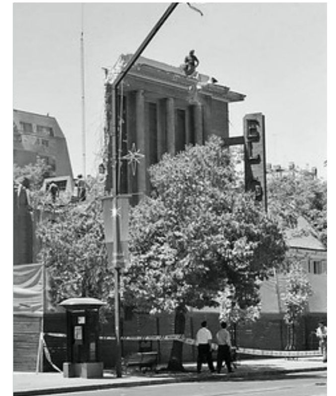
Demolición Cine El Golf
