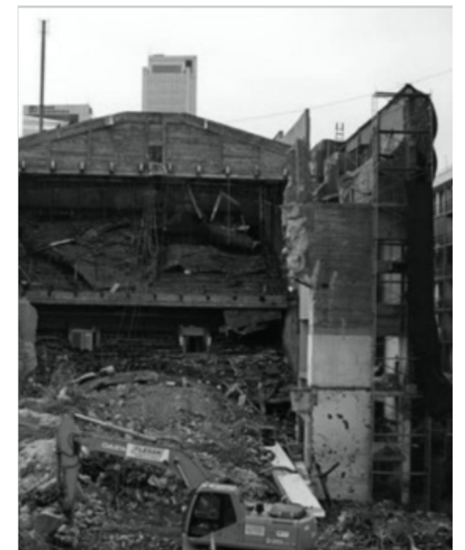
Demolición Teatro Santa Lucía
