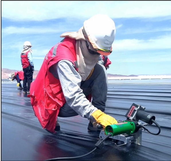
Fotografía N°1: Trabajador soldando carpeta.
