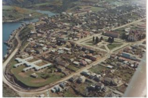
Figura 20: Vista aérea de Castro, tras el terremoto de 1960.
