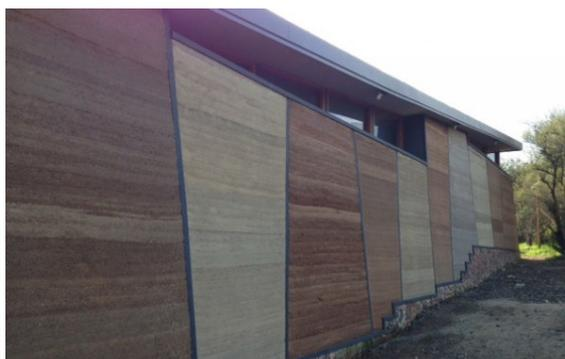
Fig. 9: Casa Munita Gonzales en sistema constructivo Terra-Panel. Fuente: Elaboración Propia
