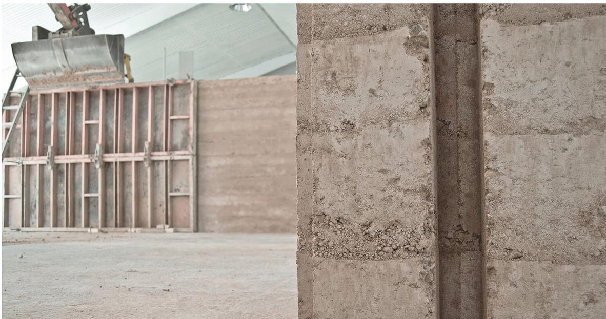
Fig. 6: Encofrado Muros tapial block. Fuente: Fedeterra, España: <https://www.fetdeterra.com/proyectos/>
