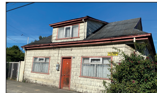
Figura 29 : Casa chilota en la ciudad de Castro. Fuente: Elaboración propia, 2021.
