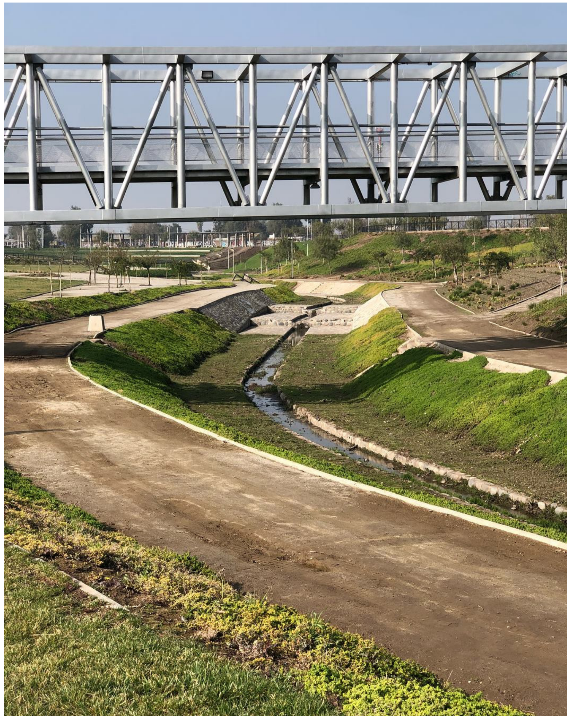
R-5 Canalizacion de agua, parque hondanada de Cerro Navia fuente: Google
