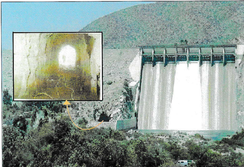
Figura 8. Túnel embalse La Paloma.
