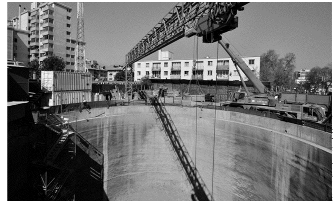
Figura 4. Construcción de Línea 3. Fuente: La Cuarta
