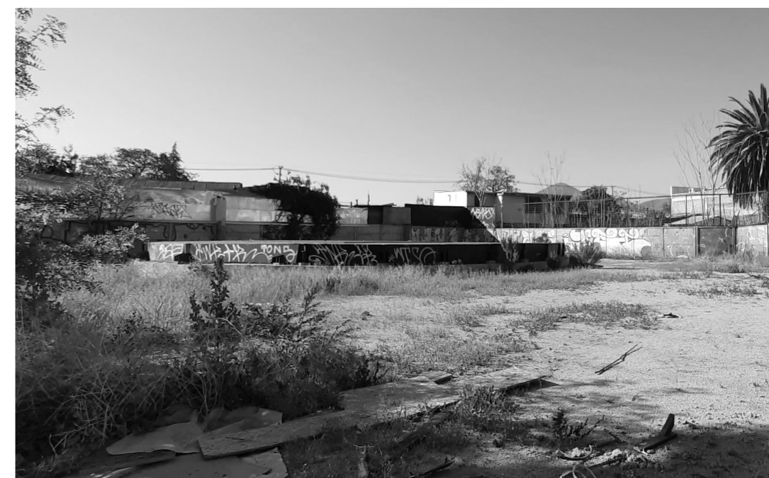
Figura 2: Pique de Ventilación de línea 3 de Metro. Fuente: Imagen de autoría propia.
