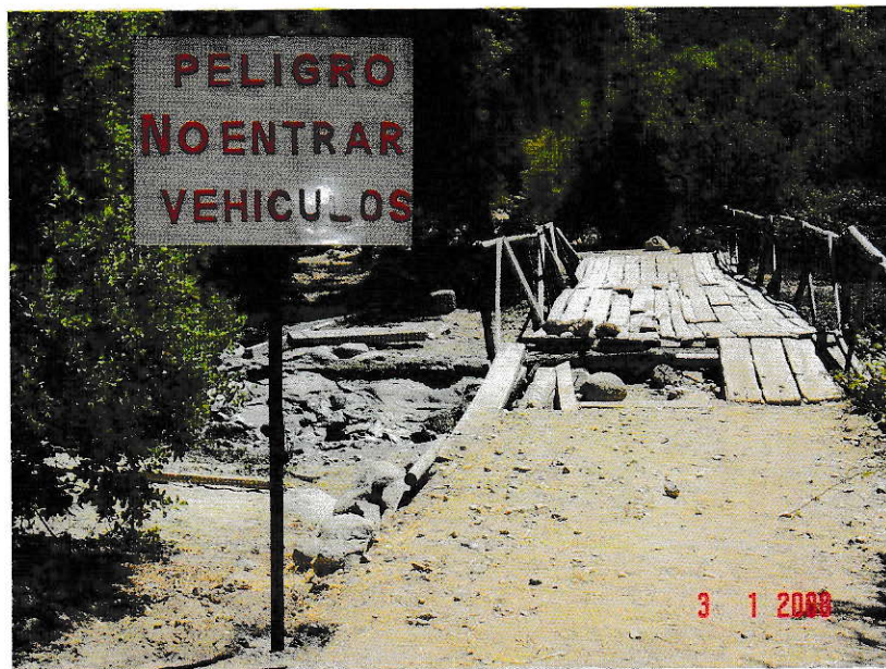
Figura 24: Señalética establecida como medida de mejora en la infraestructura del campamento Lo Salinas.
