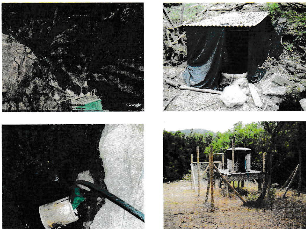
Figura 9: Sistema de captación de agua para consumo campamento Carén
