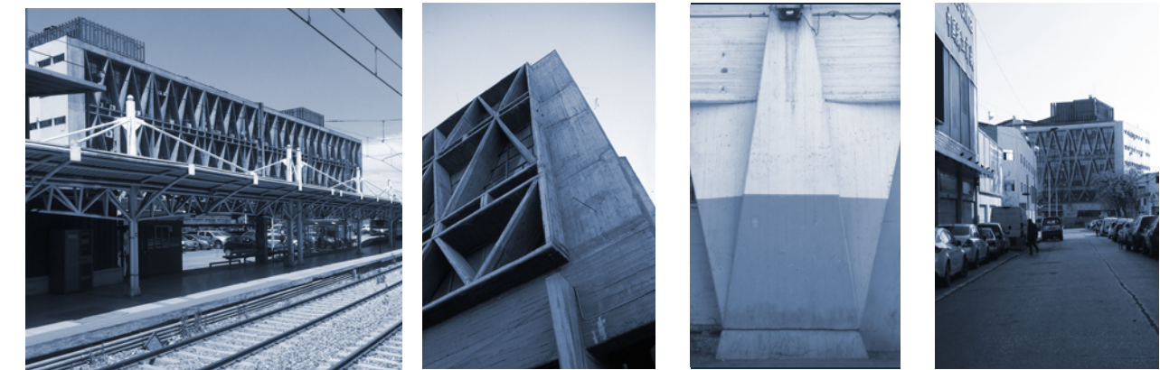
Figura 22. Fotografías exteriores del edificio y su contexto
