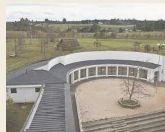
Imagen 54: Museo mapuche de Cañete . Fuente: Ministerio de Obras Públicas. (2016). Guía de diseño arquitectónico mapuche para edificios y espacios públicos. Santiago. Accedido el 1 de noviembre de 2021.
