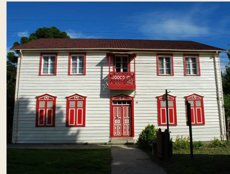
Imagen 27: Casa Schultmeyer, construida en 1898, ubicada en la Calle Millaray junto al estero El Peral. Se aprecia un volumen simple, con un constante ritmo entre los vanos y la puerta, y su destacada ornamentación. Fuente: Asociación-Patrimonio-Cultural-Alemán-de-Contulmo
