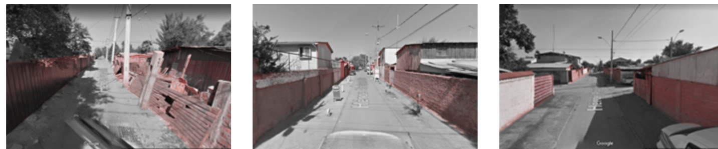
Fig 68, 69 y 70 Imágenes vías deterioradas Fuente: Google Maps
