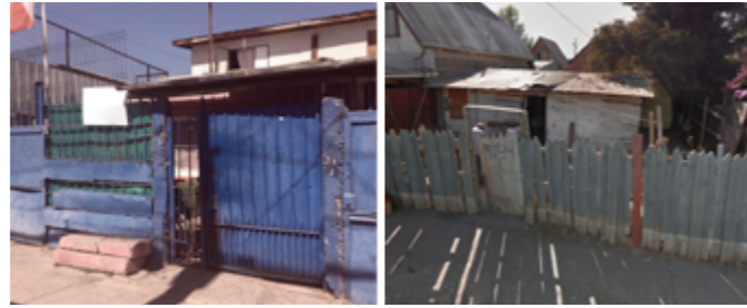
Fig 48 y 49. Vivienda deteriorada
