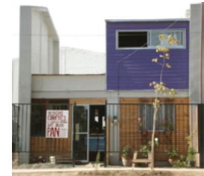
Fig. 20. Casas Chubi, Peñalolén. Fuente: Plataformaurbana.cl
