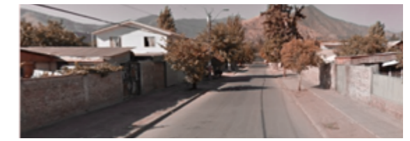
Fig 44. Imagen calle tipo Fuente: Google Maps
