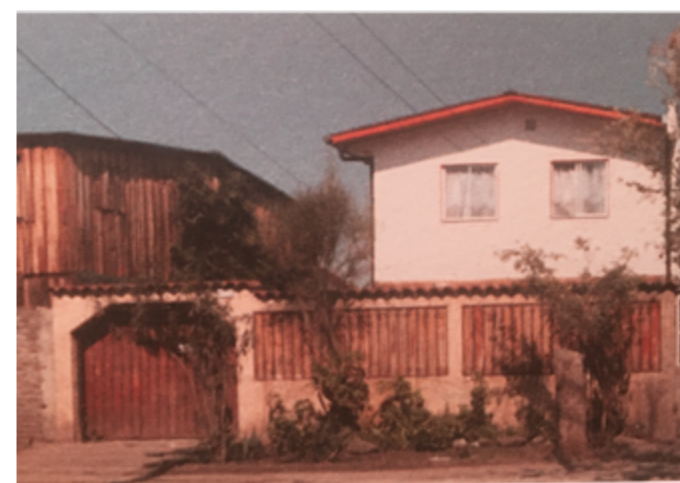
Fig x. Obra de mejoramiento de vivienda ya realizada
