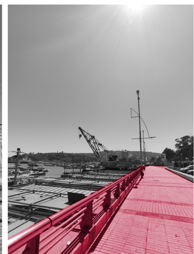
Paseo estrecho- vista deteriorada
