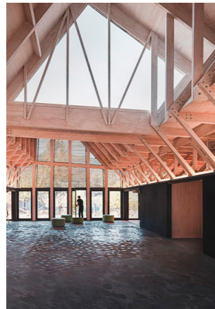
Fig. 15 Espacio central Fuente: www.arquitecturapanamericana.com
