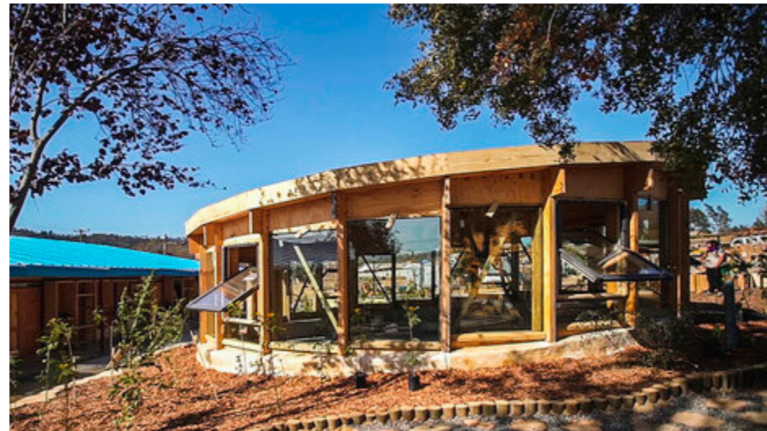
Fig. 26 Espacio multiuso Fuente: https://www.albordearq.com/una-escuela-sustentable-chile
