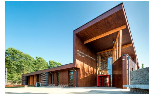
Fig. 17 Fachada principal escuela Fuente: www.plataformaarquitectura.cl
