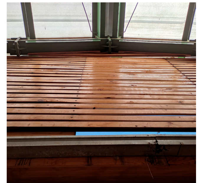
Fig. 91 Cierre perimetral patio interior entablado madera Fotografía tomada por el autor
