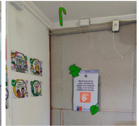
Fig. 87-88 Revestimiento interior, Planchas de volcánita yeso cartón Fotografía tomada por el autor
