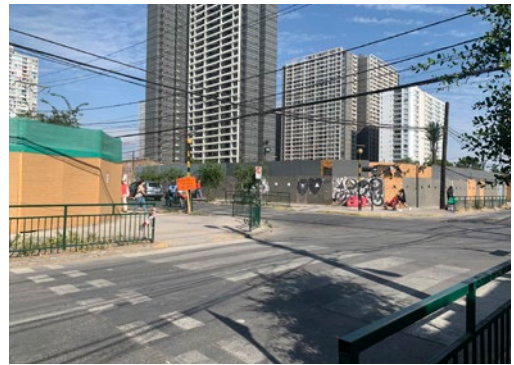
Faenas de construcción en el terreno de estudio, con conjuntos habitacionales.
