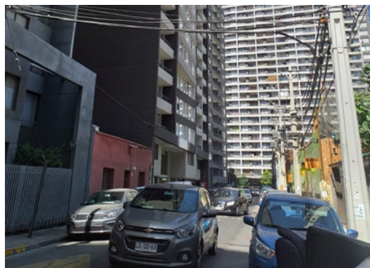
Figura 11: Congestión vehicular en Conde del Maule, conlleva a un aumento en los tiempos de traslado contrarrestando así una de las externalidades positivas del proceso, que consistía en la reducción de tiempos de traslado. Fuente: Elaboración Propia, 2020.
