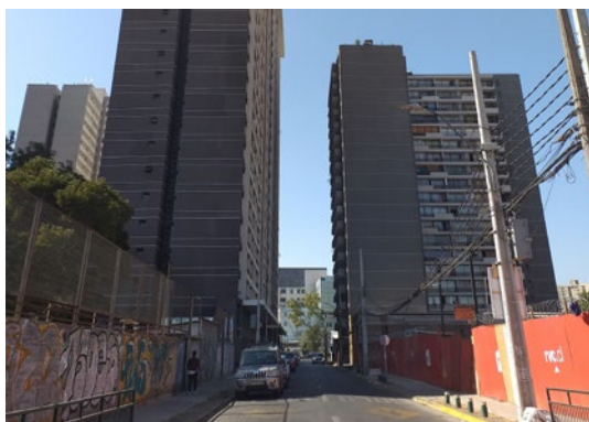
Figura 12: La altura de las edificaciones genera grandes conos de sombras, contaminación visual, producto de la escasa separación entre edificios y su concentración entorno a eje Radal. Fuente: Elaboración Propia, 2020.
