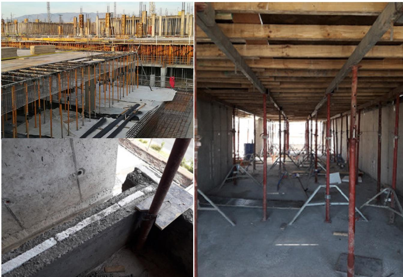
Imagen 4: Construcción en hormigón armado con sistema constructivo tradicional.
