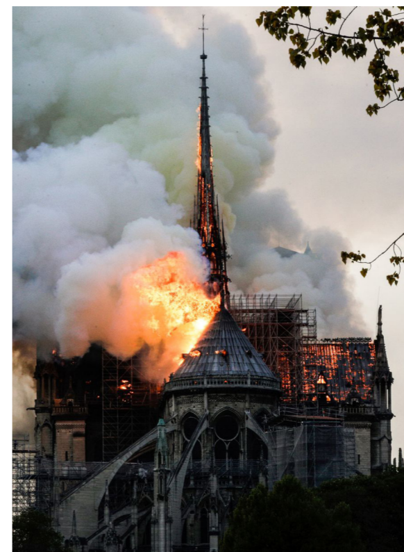
Figura 23. Notre Dame en fuego 2019. Destrucción de arquitectura a manos del fuego.
