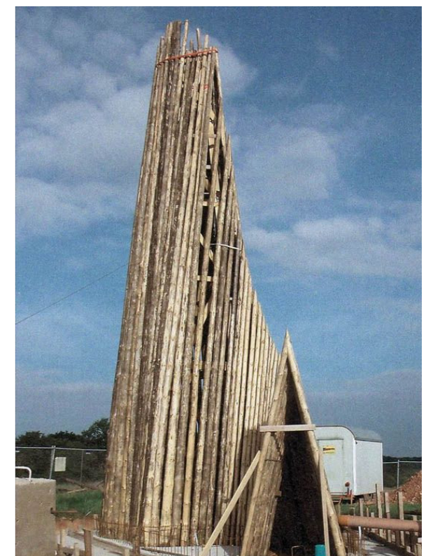
Figura 24. La capilla Bruder Klaus de Peter Zumthor, cuyo interior fue construido a base e troncos los cuales posteriormente fueron cubiertos en hormigón y quemados.
