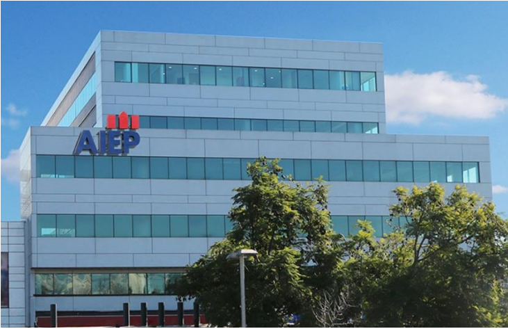
18. Fotografía de AIEP sede Maipú Fuente: AIEP.cl
