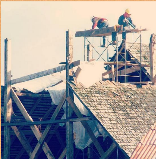
22. Restauración de la torre de la iglesia de Ichuac, Isla de Lemuy, 2006. Archivo de José Luis Catalán
