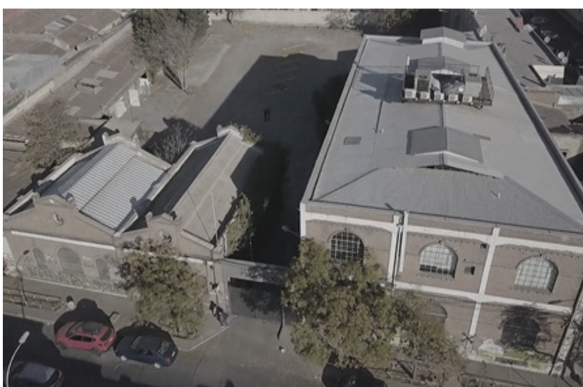
Figura 32: Subestación de acumulación y distribución en 2019 Fuente: http://www.munistgo.info/revivestgo/municipio-adquiere-edificio-en-barrio-yungay-para-traslado-de-direccion-de-seguridad-vecinal/
