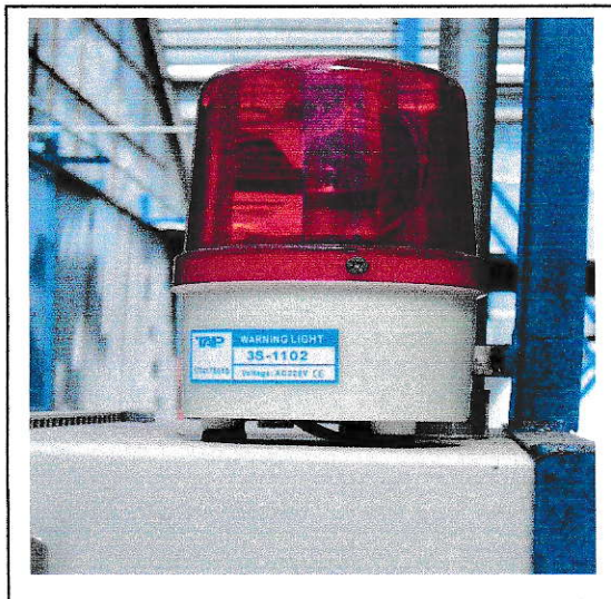
Figuras 20 y 21: Señal visual de aviso al operador y tablero eléctrico de operación de equipos.
