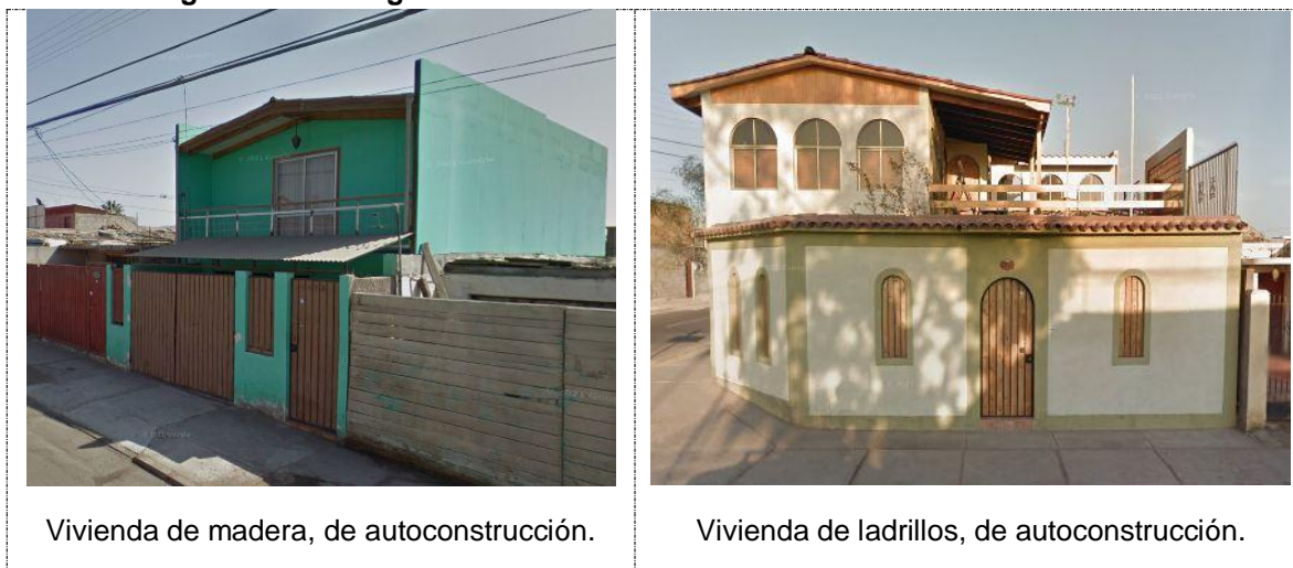
Figura N°41: Imágenes de viviendas en la zona censal 1 de J. M. Carrera
