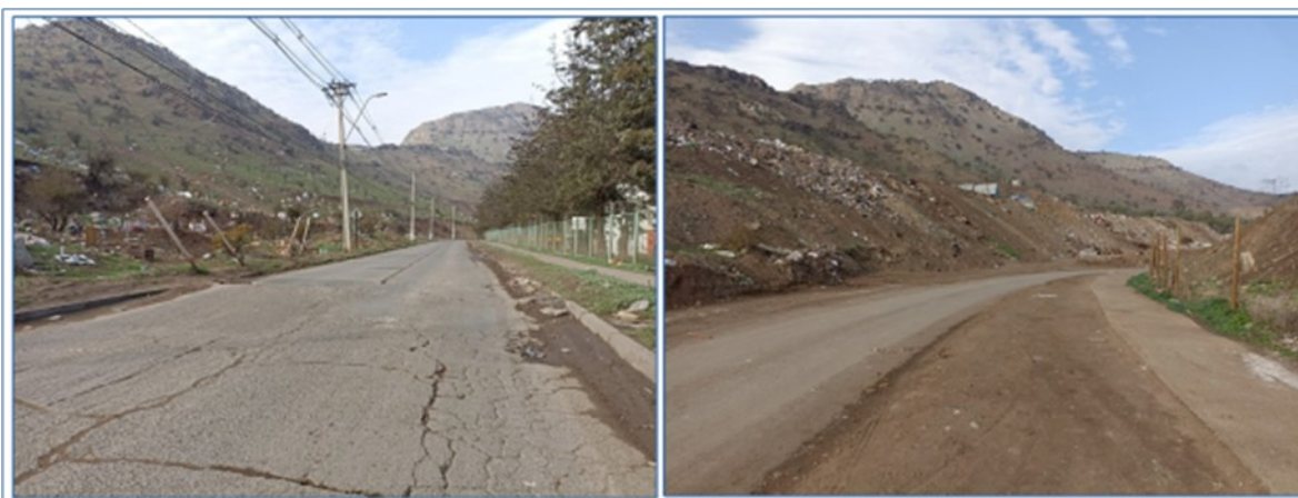
Izquierda: Calle Camino al Cementerio, altura las Catapalcas; Derecha: Calle Camino al Cementerio, sector Cementerio .
