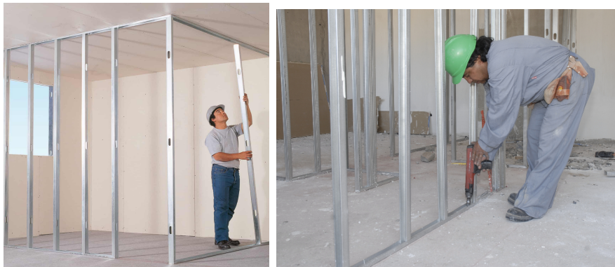
Figura 4.29: Tabiques de metalcon a utilizar. Fuente: https://images.google.com/
