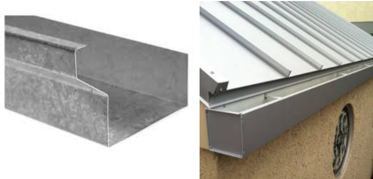
Figura 4.28: Canaletas y bajadas de lluvia de hojalata. Fuente: https://images.google.com/
