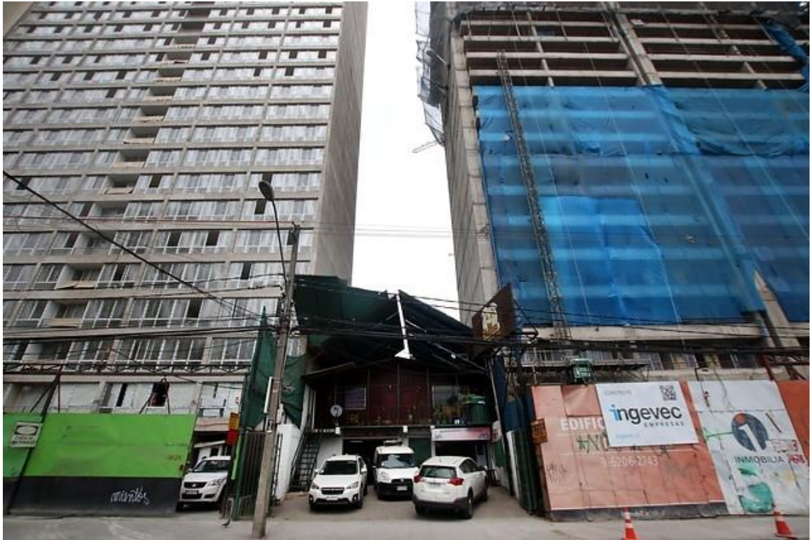
Imagen 7: Casa isla - Edificación continua
