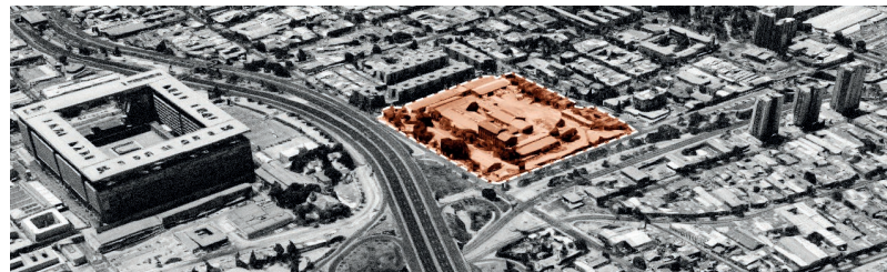
Ex Refinería de Azúcar de Santiago, Santiago Sur. Fuente: Elaboración propia.
