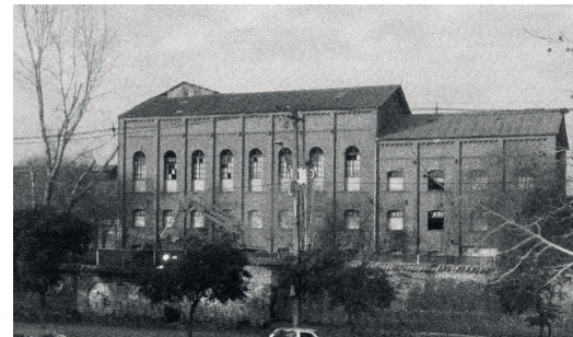
Ex Refinería de Azúcar de Santiago, Santiago Sur. Fuente: Elaboración propia.
