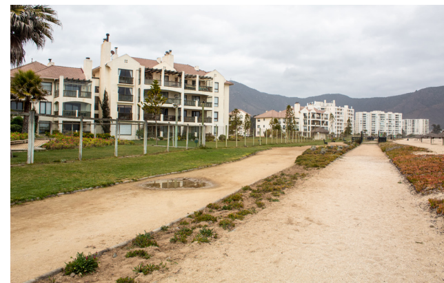
Figura 74. Deterioros de tramos en el paseo. Fuente propia.
