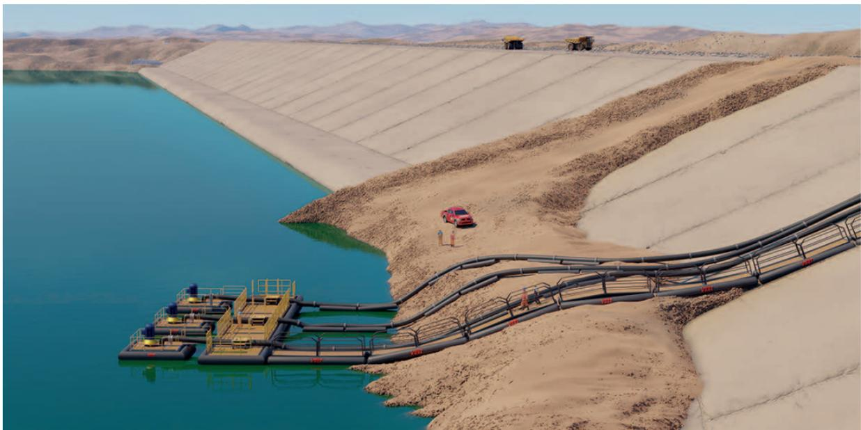
Figura 6.2: Ejemplo de captación en un embalse mediante bombas en balsa de eje vertical. Fuente: vogt.cl
