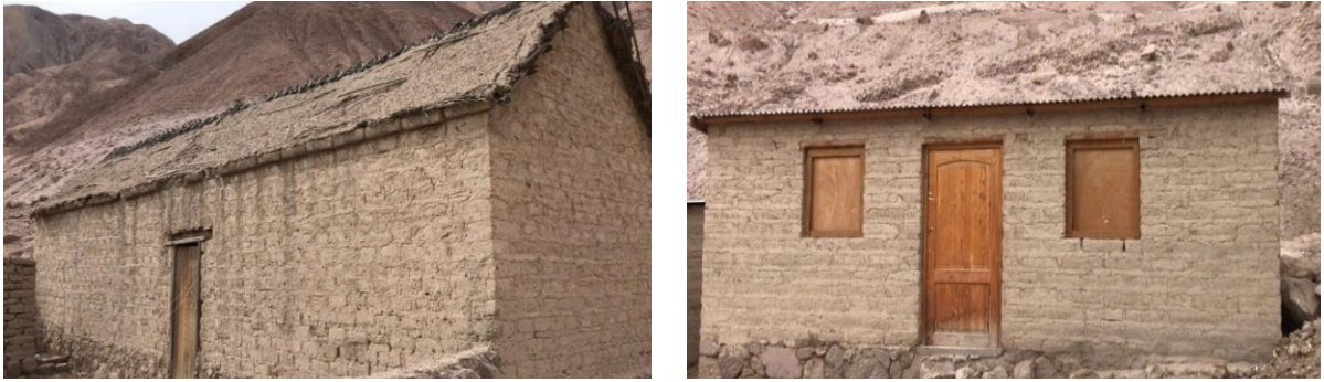
Figura 3.2-12: A la izquierda la vivienda C2-1 con techo de paja y barro. A la derecha la vivienda C3-5 modificada con techo de acero galvanizado.
